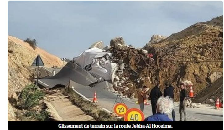
Glissement de terrain sur la route Jebha-Al Hocelma.
